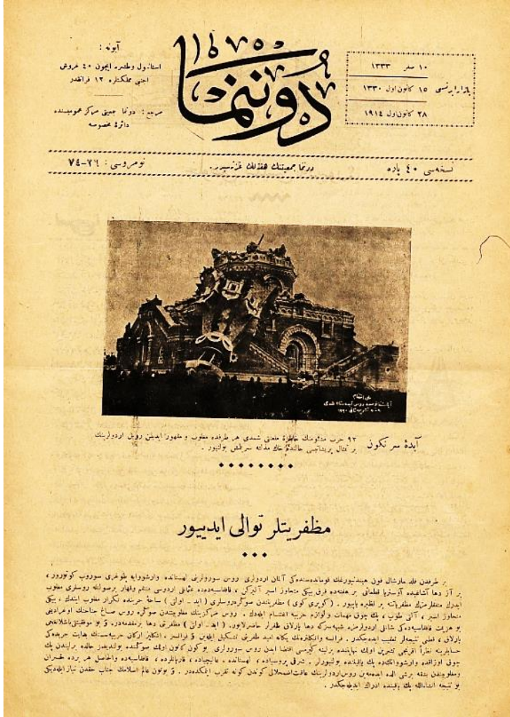
Resim 3. Ayastefanos anıtının yıkımdan sonra
