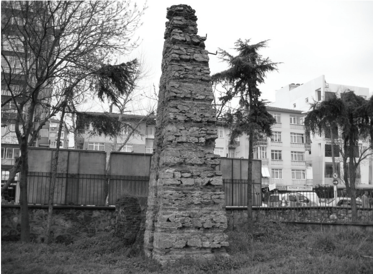
Kurbağaldere Çiftliği'ne su sağlayan isâle hattındaki su terazisi, Göztepe Eğitim ve Araştırma Hastanesi'nin bahçesinde bulunmaktadır.
