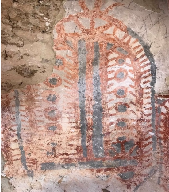
Fotoğraf 8: İsa Sofu Türbesi iç mekan detayı.
